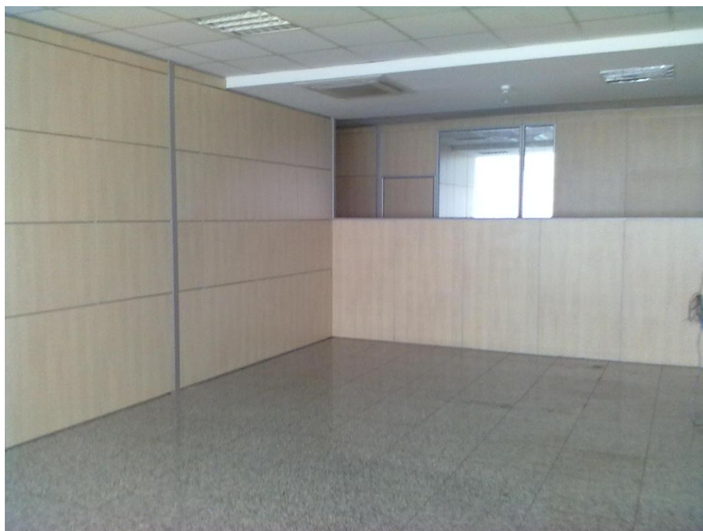
Divisória modulada removível piso ao teto (painel cego). Altura (pé direito): 2,85m Divisória modulada removível piso – 1,62 MTS (painel cego)
