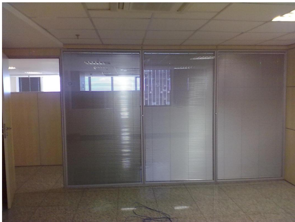
Divisória modulada removível, piso ao teto (painel de vidro duplo com película de segurança e micro persiana) Altura (pé direito) – 2,3m
