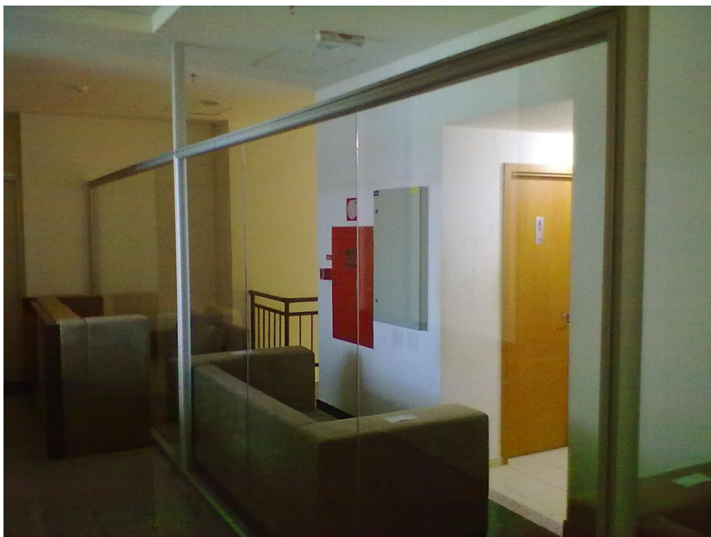
Divisória modulada removível piso - painel vidro simples Altura (pé direito) – 2,3
